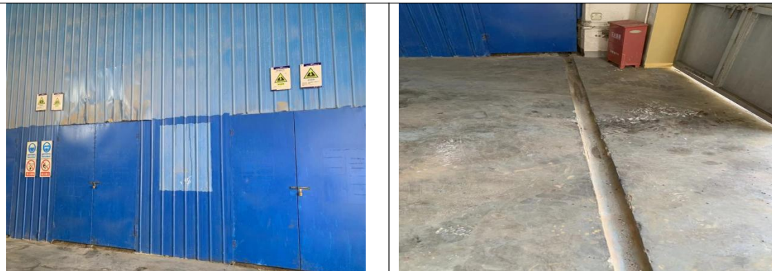
生产车间：厂区各车间生产过程中原料泄露可能对土壤和地下水产生污染，现场踏勘显示地面均已硬化、周边设置导流槽，地面完好无破损裂痕。
